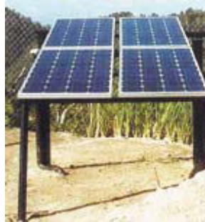
Figura 4. Conjunto de paneles fotovoltaicos típicos y su estructura metálica de soporte.
